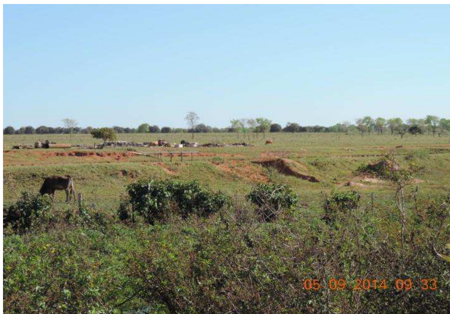
Figura 83: Alto curso da BHCM, feições erosivas na margem direita do córrego Querência, na fazenda Querência, a montante do ponto 3.
