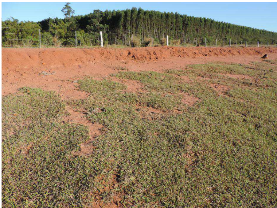
Figura 88: Médio/baixo curso da BHCM, feições erosivas às margens da rodovia MS-395.
