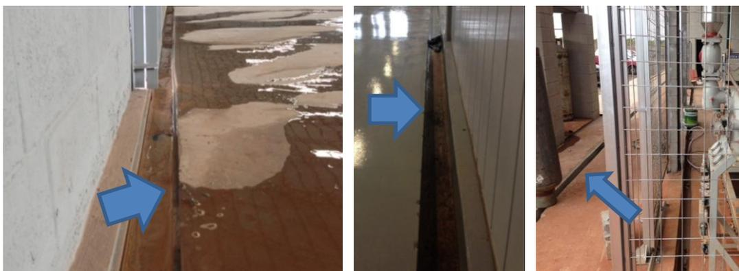
**Figura 7.7 - Canaletas de captação do Efluente**
