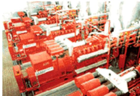
**Figura 5.1 - Motores Ciclo Otto para biogás**
