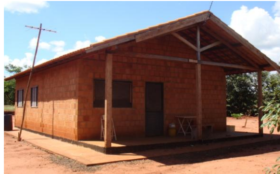
Fig. 86. Casa do Grupo FETAGRI com oitão alterado para tesoura em madeira Fonte: do Autor
