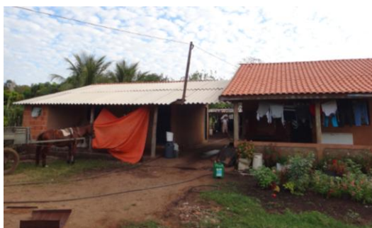
Fig. 90 - Construção de varanda longitudinal Fonte: do Autor (2014)
