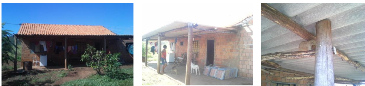
Fig. 89 - Construção de varanda - Estrutura de cobertura em eucalipto e telhas de fibrocimento Fonte: do Autor (2014)
