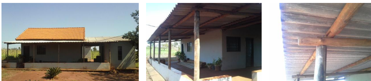
Fig. 88 - Construção de varanda - Estrutura de cobertura em eucalipto e telhas de fibrocimento Fonte: do Autor (2014)
