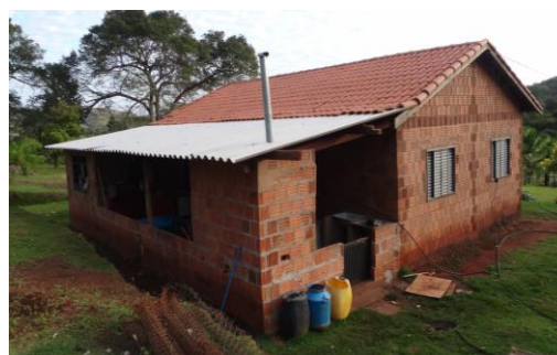
Fig. 91 - Construção de varanda lateral Fonte: do Autor (2014)
