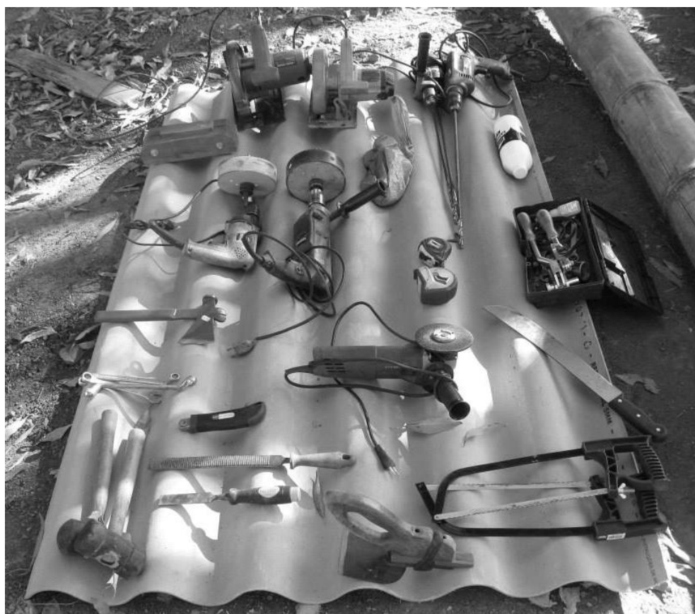
Fig. 93 - Ferramentas para montagem da estrutura de cobertura
