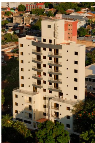
Figura 3.11 - Vista Edifício Fortaleza III
