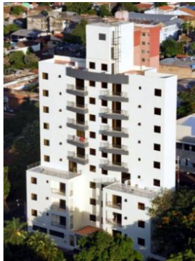
Figura 4.12 - Fachada Edifício Fortaleza III.
