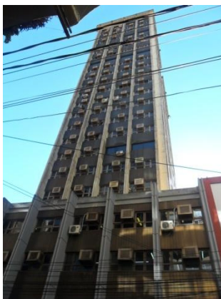
Figura 3.6 - Fachada principal Edifício Líder IV
