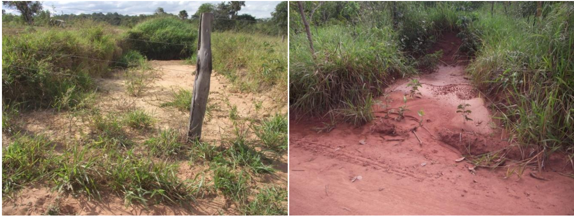
Figura 36- caixas de contenção, utilizada como prevenção e controle de escoamento superficial e sedimentos.
