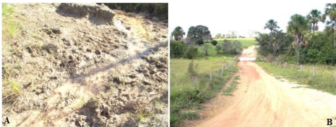
Figura 29- Pisoteio do gado nas áreas de veredas (a), estradas irregulares em áreas de veredas (b).
