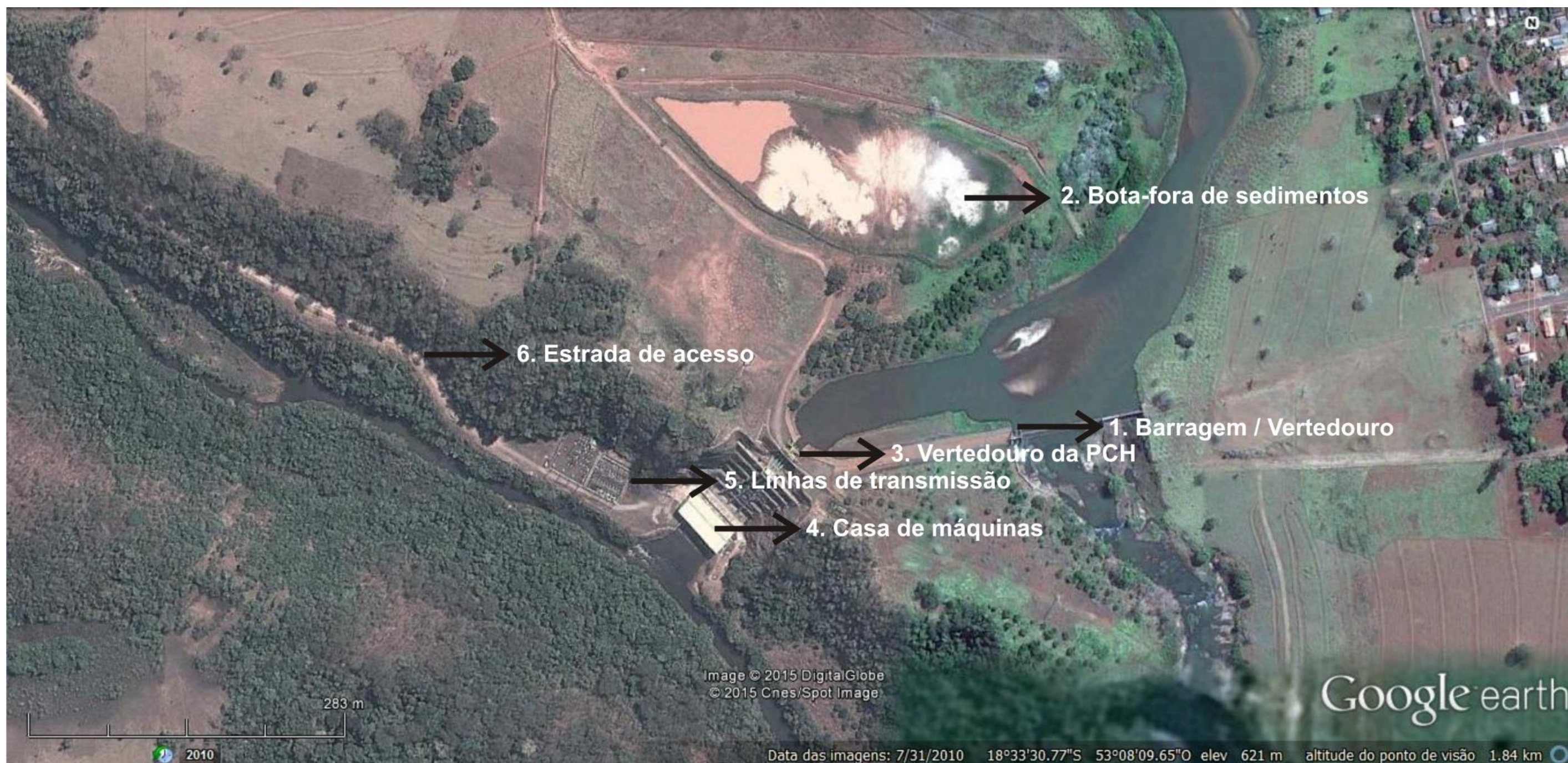
Figura 12 - Edificações da PCH Costa Rica. Fonte: Google Earth®
