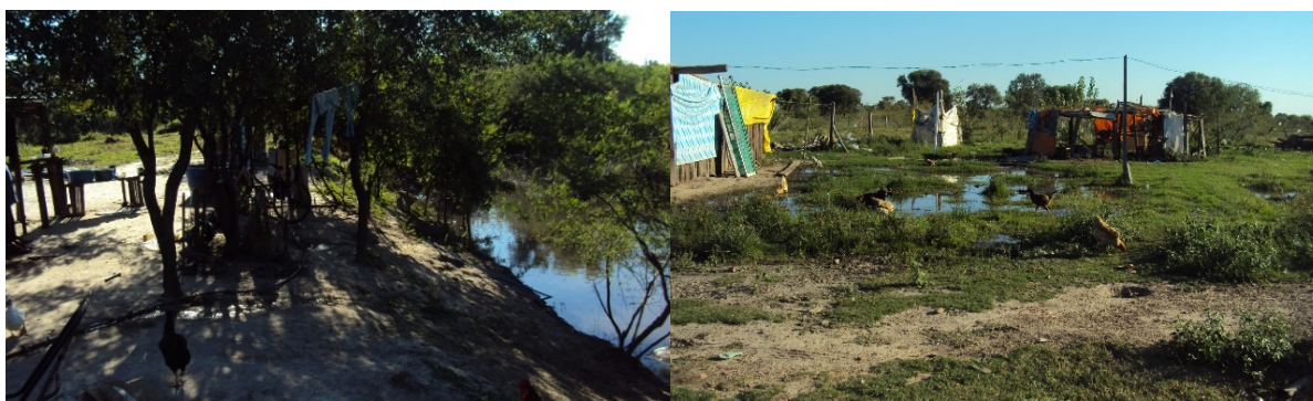
Figura 36 - Esgoto residencial próximo a canal hídrico Figura 37 – Esgoto ao lado das casas
