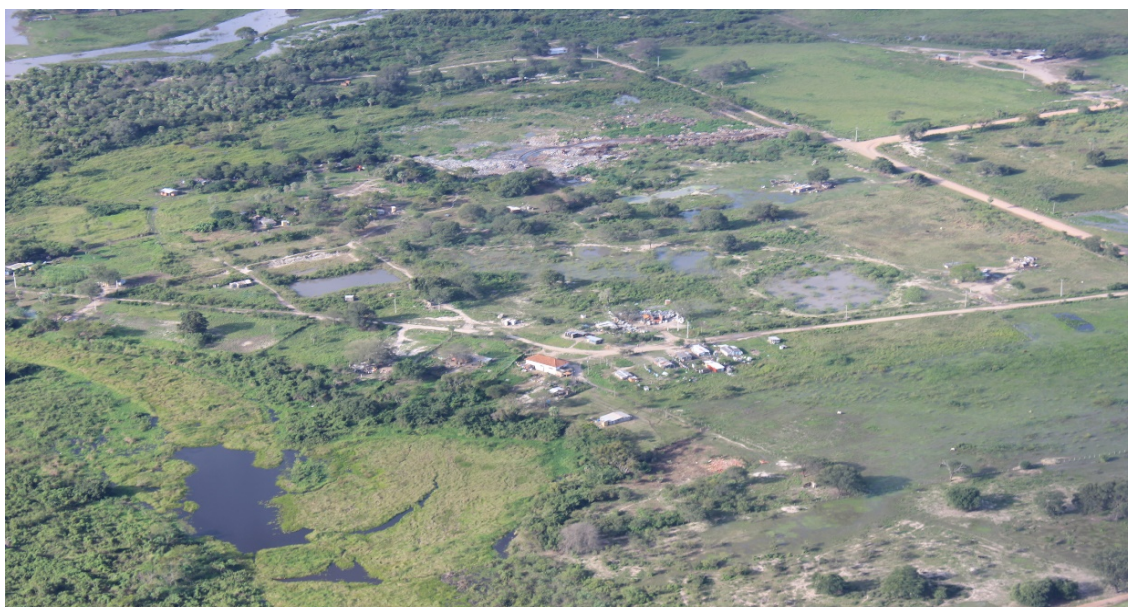
Figura 27: Inundação no Lixão Municipal e o rio Amonguija ao fundo
