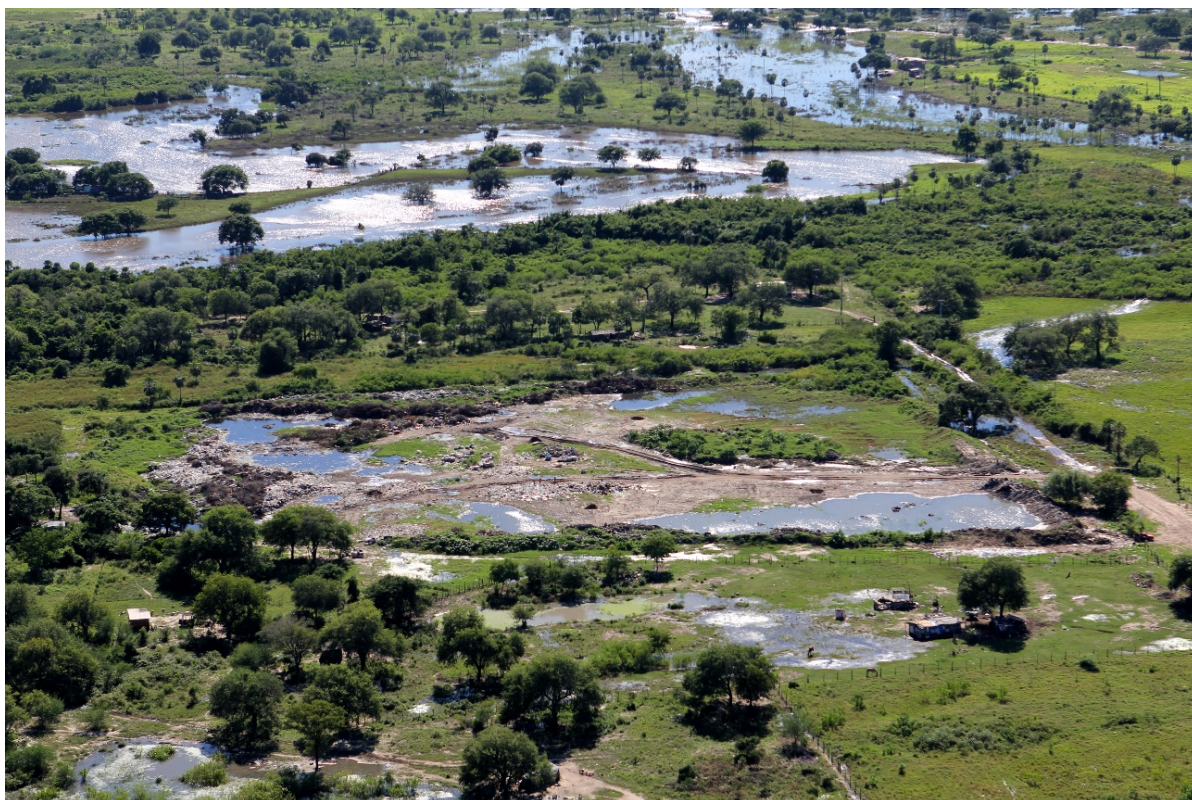
Figura 34: Vista Aérea do Lixão Municipal de Porto Murtinho – MS com Chorume Empoçado
