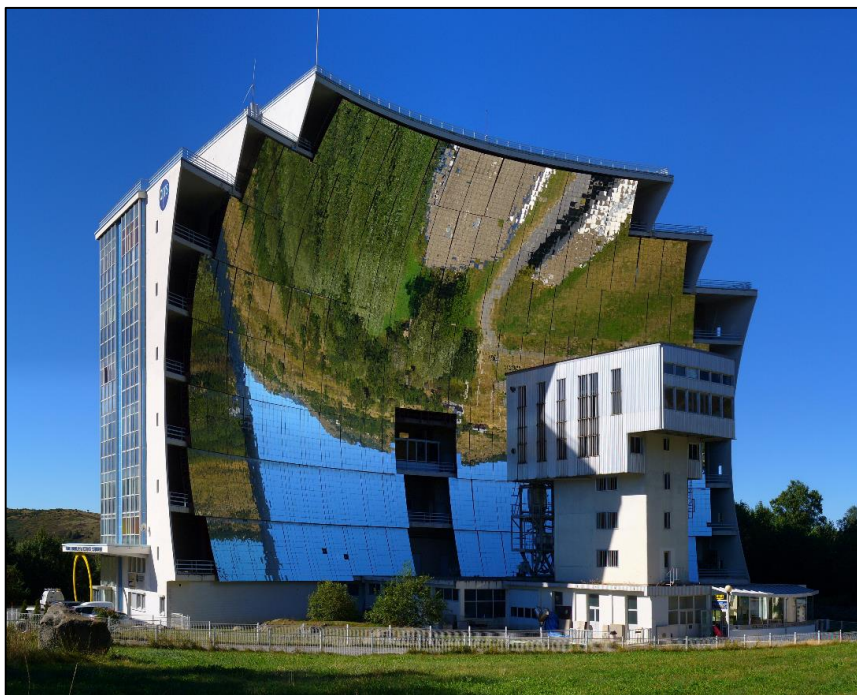
Figura 3.14 - Aplicação do parabolóide - Forno solar - Odeillo, sul da França. Fonte: http://upload.wikimedia.org/wikipedia/commons/9/99/Four_solaire_005.jpg
