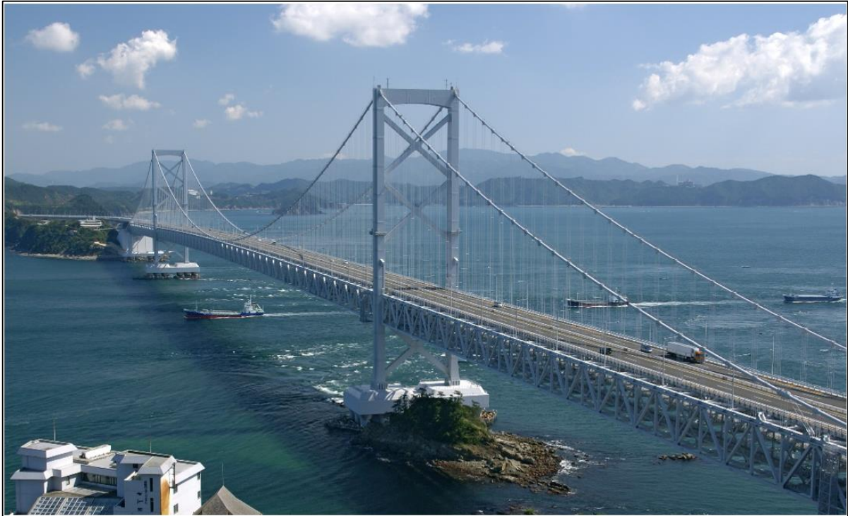
Figura 3.5 - Aplicação da Parábola na construção da Ponte Pênsil - Ponte Naruto situada no Japão. Fonte: http://upload.wikimedia.org/wikipedia/commons/b/bf/Big_Naruto_Bridge05n3872.jpg
