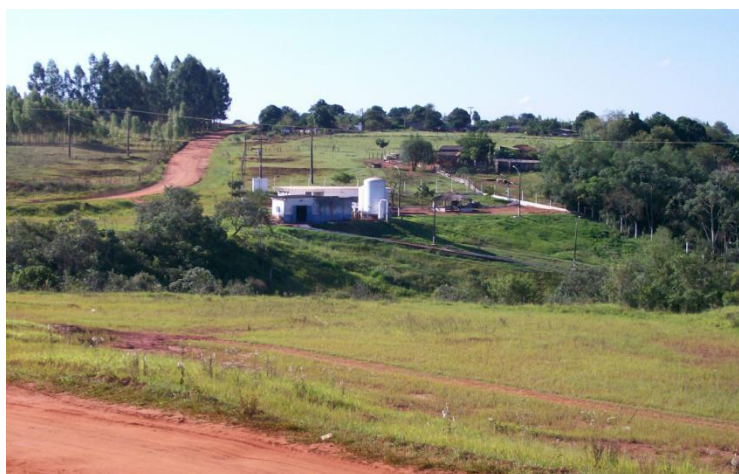
Figura II.2 (a) – Estação de Tratamento de Água SANESUL
