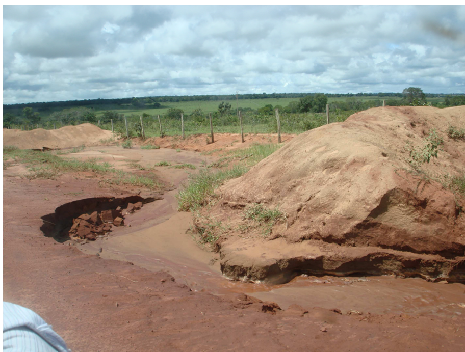
FOTO 5. – Lateral de um trecho da estrada de acesso e travessia da bacia, demonstrando a fragilidade do solo.
