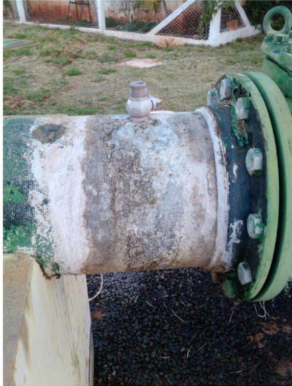
FIGURA 5.5: Detalhe da tubulação com mineral depositado em sua superfície, característica particular do poço CGR-213, localizado no bairro Novos Estados.
