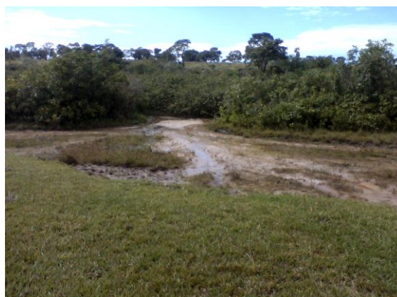
Ponto 4- Erosão Córrego.
