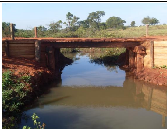
Ponto 2 - Ponte sobre o córrego
