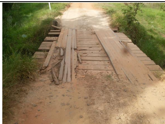
Ponto 1- Ponte sobre o córrego
