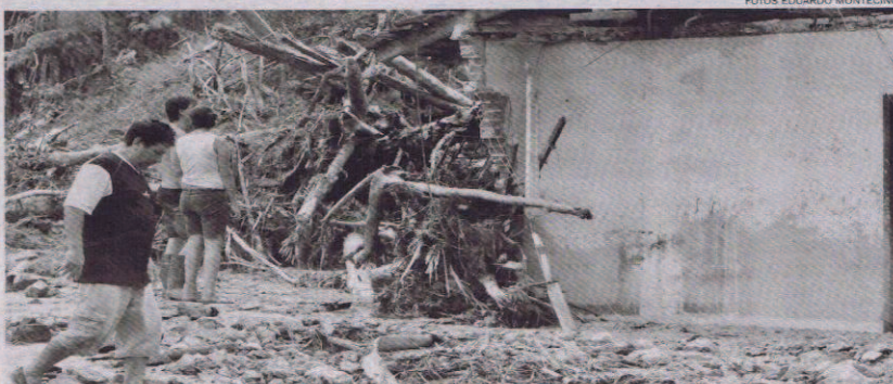
Parte da casa de Lauro Mocua foi levada pelo barro que caiu do morro, na noite de quarta-feira
