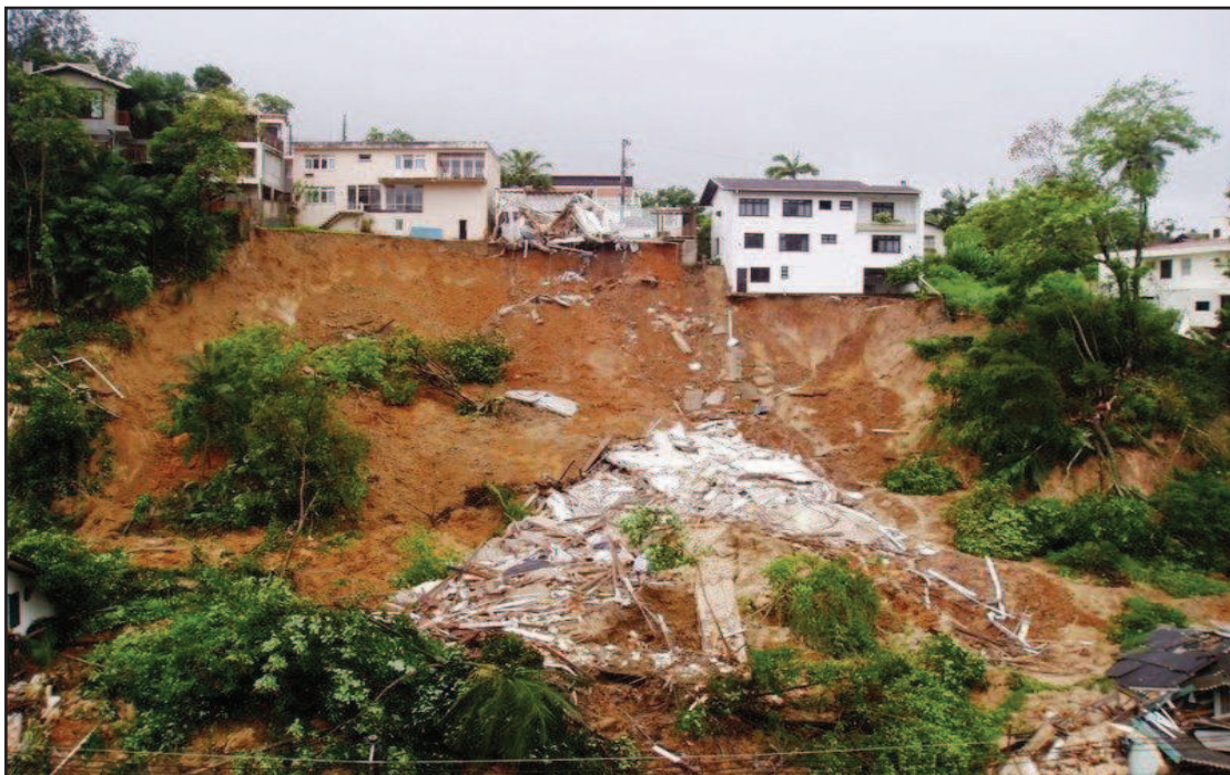
Figura 5: Deslizamento de Encosta com construções prediais, no verão de 2008, Blumenau – SC
