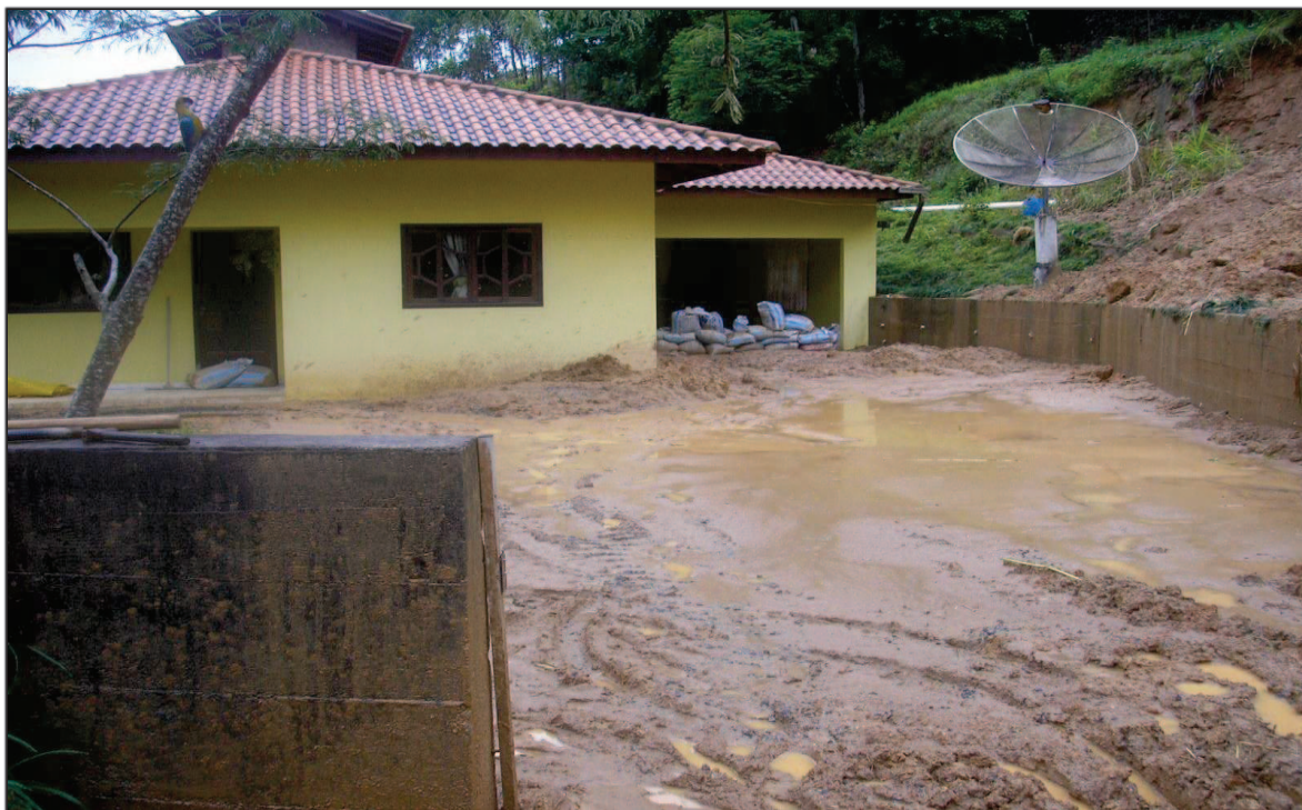
Figura 26: Casa atingida no bairro Barra do Rio Molha deslizamento. Fonte: Defesa civil. Cedido pelo Arquivo Histórico Eugênio Victor Schmockel.
