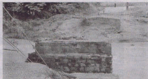
No bairro Garibaldi, pontes, tanto de madeira como de concreto, ficaram totalmente destruídas
