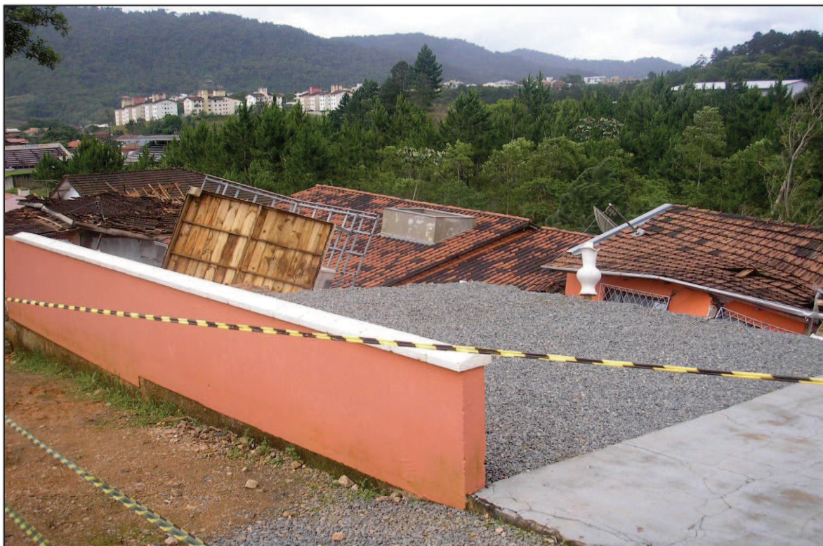
Figura 28: Deslizamento de terra, bairro Jaraguá Esquerdo.
