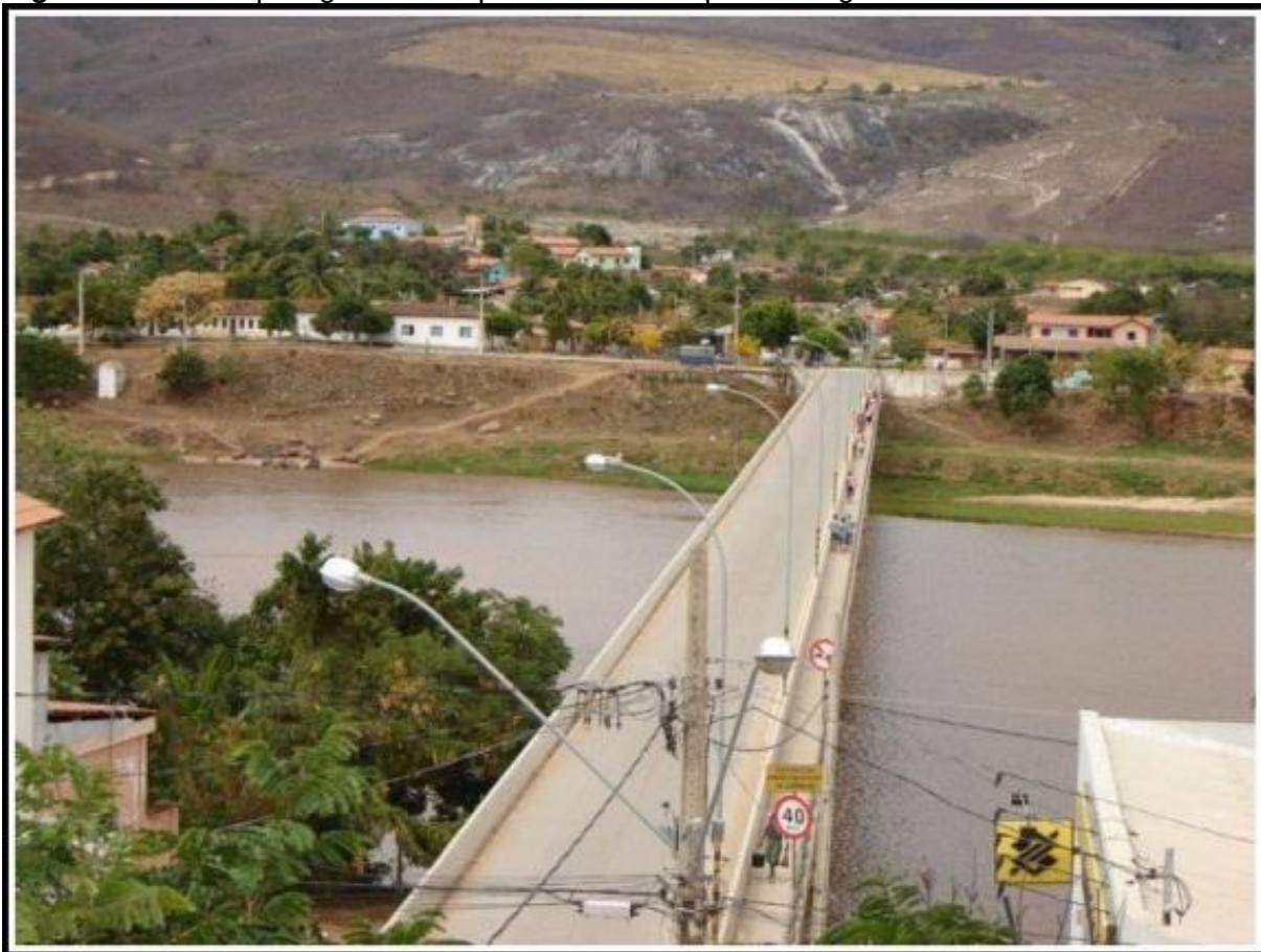
Figura 4 – Ponte que liga as duas partes do município de Itinga/MG
