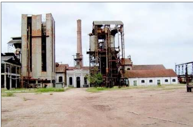
Figura 22: Vista da entrada principal do Engenho Central de Quissamã/RJ. Fonte: Prefeitura Municipal de Quissamã, 2007.
