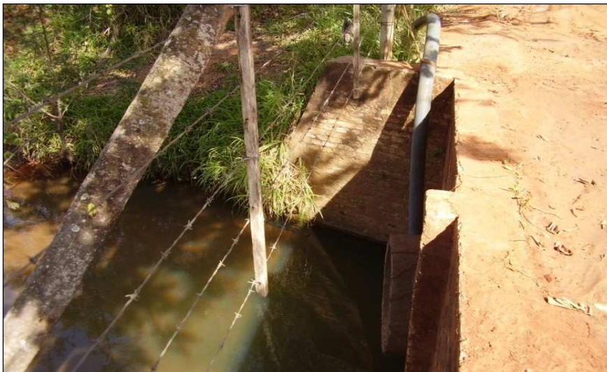
Figura 31: Mangueira de abastecimento de caminhões-pipas para controle de queimadas nos canaviais em Mirandópolis/SP. Foto: QUINTINO LEAL, 2010.
