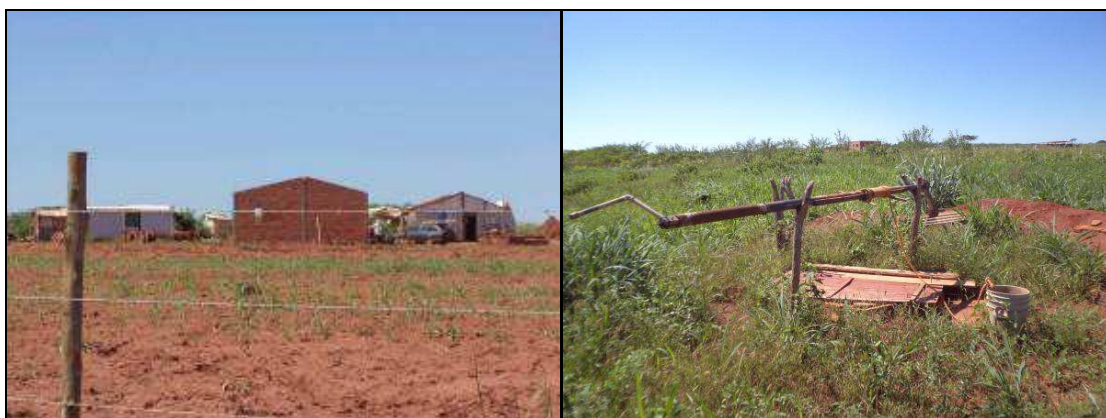
Figura 6 – Construção de casa no assentamento Pendengo em Castilho-SP, ao lado poço de água escavado por assentado.
