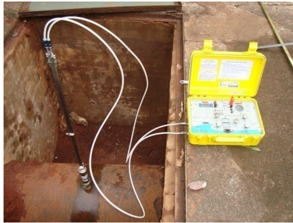
Figura 4.2 – Medidor de Vazão.
