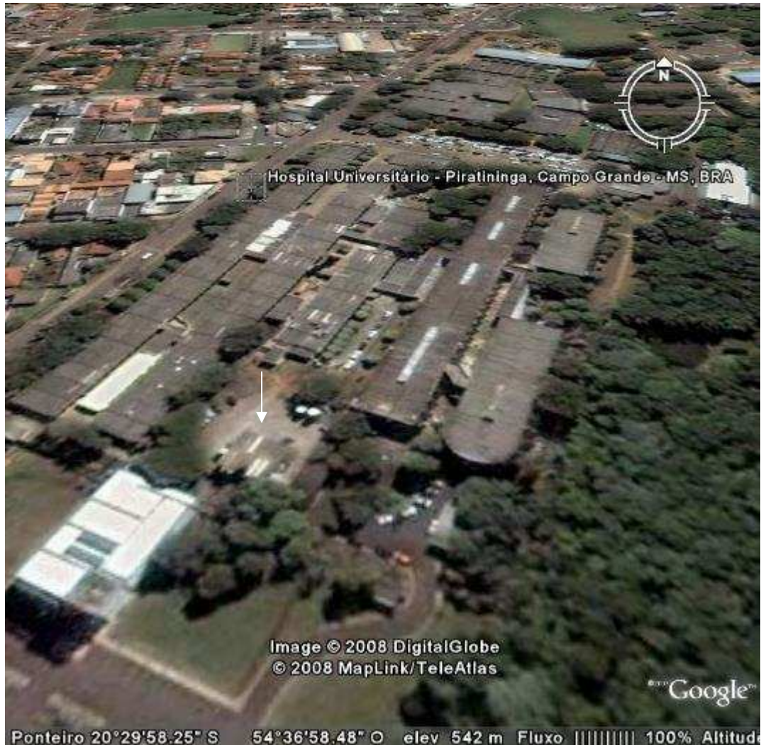
Figura 4.2 – Localização da casa de caldeiras do NHU
