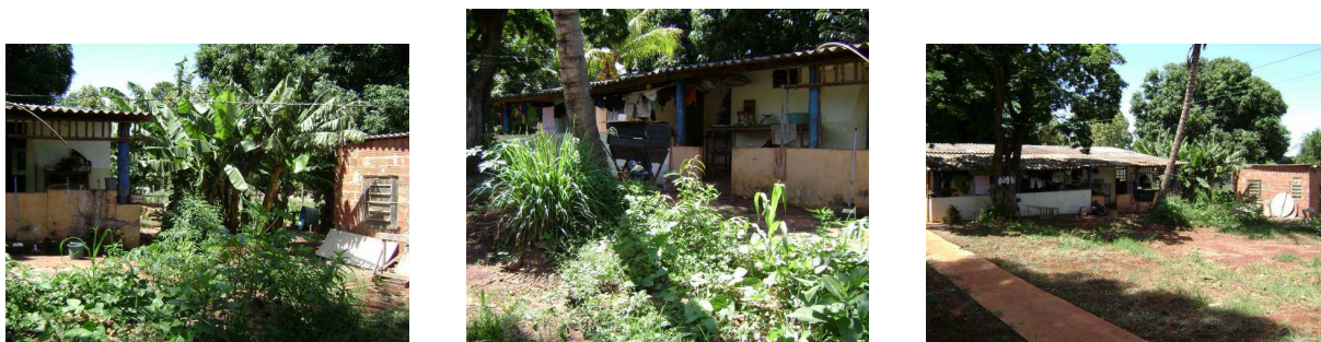
Residência onde o projeto foi instalado, antes da execução.
