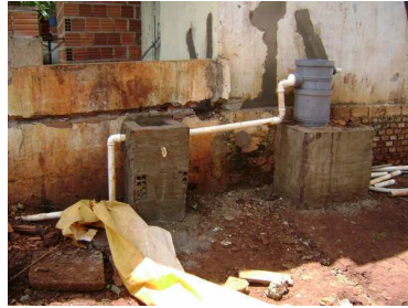
Construção do suporte para a caixa de gordura e da caixa de passagem/inspeção.
