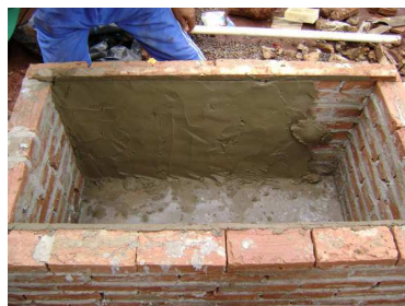
Construção do Tanque de Sedimentação – impermeabilização.
