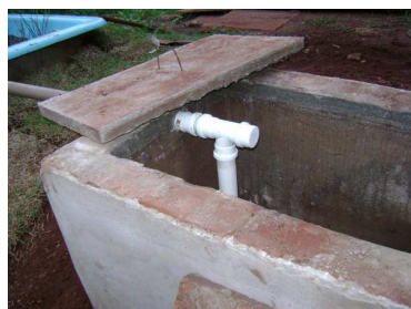
Tanque de Sedimentação.
