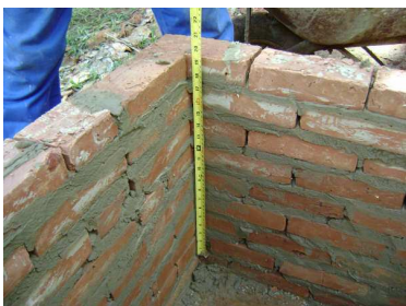
Construção do Tanque de Sedimentação – impermeabilização.
