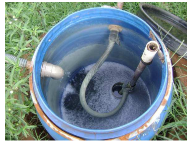
Construção da estrutura para o tanque de alimentação intermitente.
