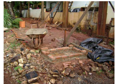
Construção do Tanque de Sedimentação – alicerce e reforma da casa.
