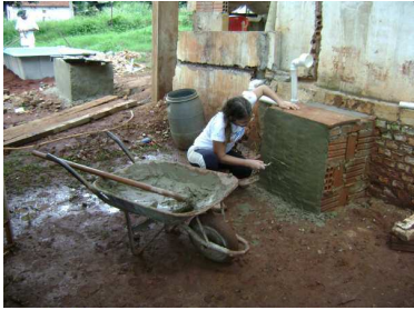
Construção do suporte para a caixa de gordura e da caixa de passagem/inspeção.
