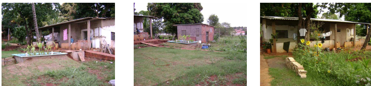
Residência onde o projeto foi instalado após a execução do projeto.
