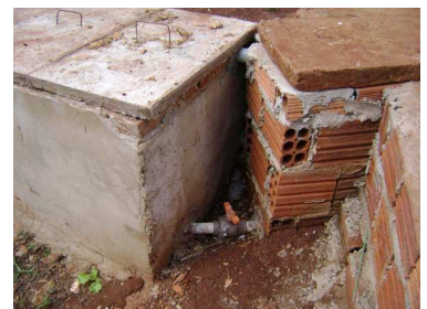
Construção do Tanque de Sedimentação – impermeabilização.
