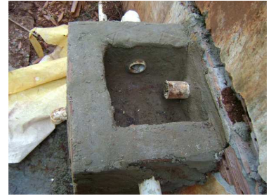
Construção do suporte para a caixa de gordura e da caixa de passagem/inspeção.
