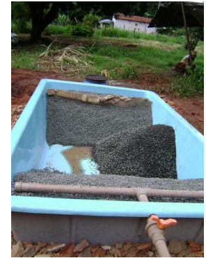
Construção do wetland de fluxo horizontal subsuperficial (CW-FH).
