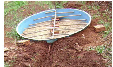
Construção e preenchimento do wetland de fluxo vertical (CW-FV).
