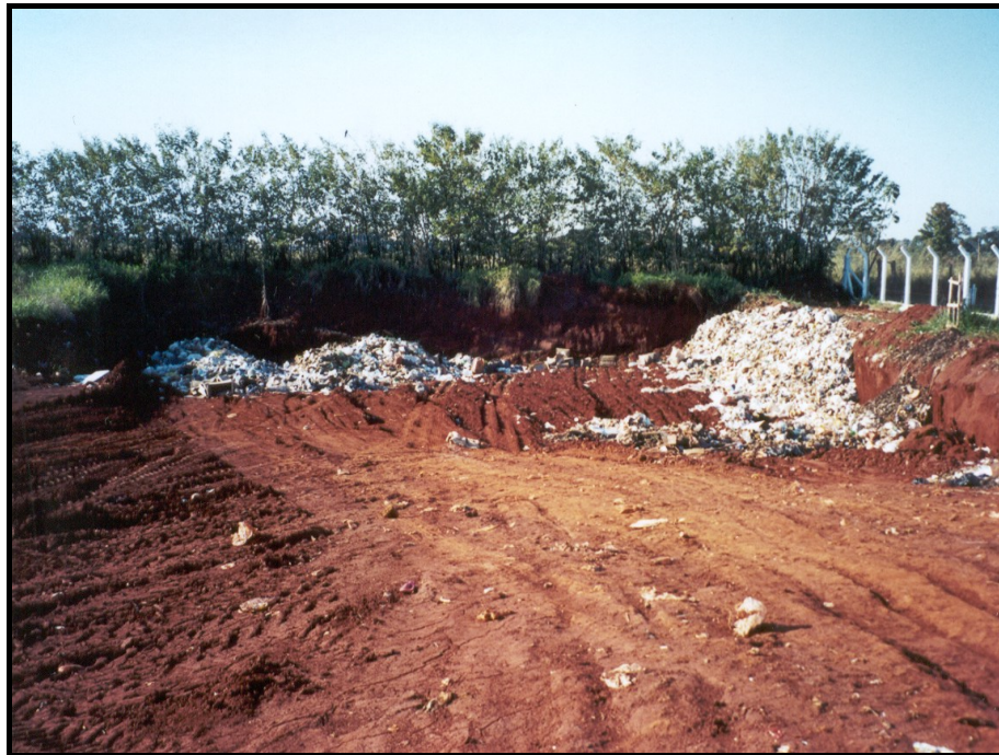
Figura 5.6 - Aterro de rejeitos
