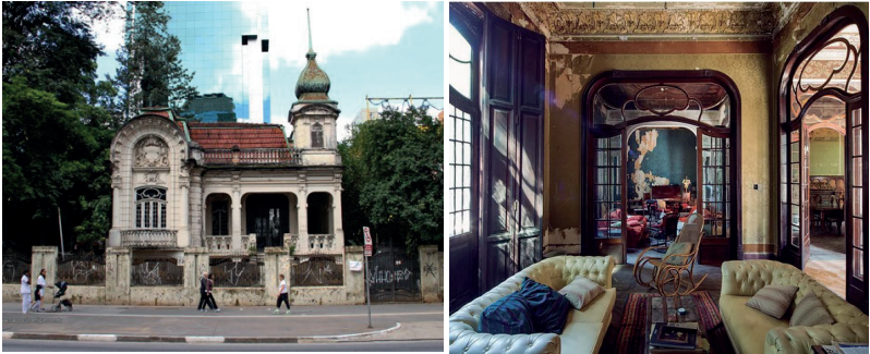
Figura 7.3: Casarão Franco de Mello, vista externa e interior em registro de 2023. Projetado em 1905, é obra do construtor português Antônio Fernandes Pinto (1905). Fotos: Douglas Nascimento (2023) e Pedro Napolitano (2019).
