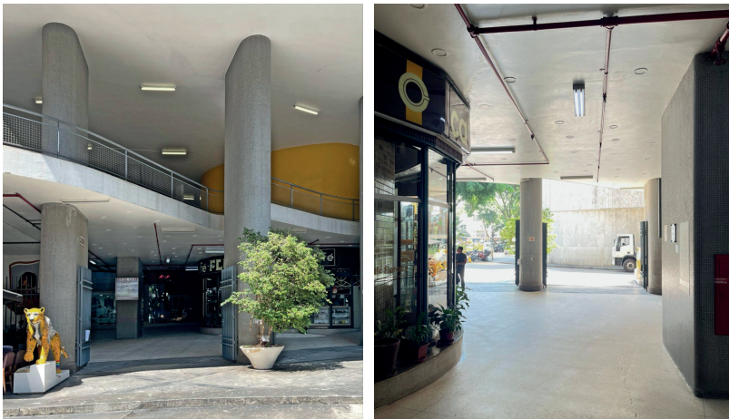
Figura 7.11: Acesso à galeria do edifício COPAN, São Paulo. Fotos: Ricardo Almeida (2025)
