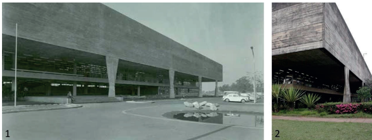
Figura 3.7: Imagem 1 - Vista lateral da FAU/USP, após a sua construção e Imagem 2 - Destaque para os pilares das fachadas. Fontes: Imagem 1: Camargo (2011) e Imagem 2: Fernando Stankuns. Disponível em: http://www.archdaily.com/799088/ad-classicsfaculty-of-architecture-and-urbanism-university-of-sao-paulo-fau-uspjoao-vilanova-artigas-and-carlos-cascaldi . Acesso em 24 de fev. 2025
