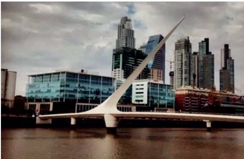
Figura 01: Vista da Puente de la Mujer, em Buenos Aires, obra do arquiteto e engenheiro espanhol Santiago Calatrava (2001). A estrutura metálica assimétrica funciona como ponte giratória e elemento escultórico, integrando arte e engenharia na paisagem portenha. Foto: Ricardo Bitencourt (2006).
