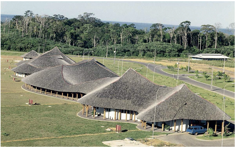
Figura 13.2: Severiano Mário Porto e Mário Emílio Ribeiro: Centro de Proteção Ambiental de Balbina/AM. Fonte: Revista PROJETO (2020). Disponível em: https://revistaprojeto.com.br/acervo/severiano-mario-porto-e-mario-emilio-ribeiro-centro-de-protecao-ambiental-de-balbina-manaus-am/ . Acesso em: 23 fev. 2025.
