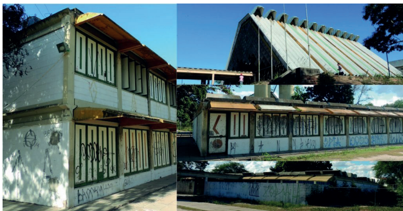
Figura 7.18: CAIC José Joffily, em Campina Grande / PB Fonte: Ivanilson Pereira (2020). Fonte: Afonso; Pereira (2020). Disponível em: https://periodicos.ufrn.br/revprojetar/article/view/20464/13254 . Acesso: 25 fev.2025
