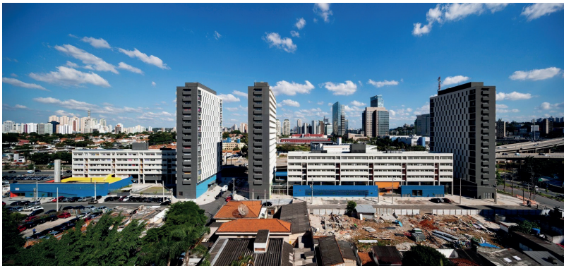
Figura 7.23: Conjunto Habitacional do Jardim Edite, São Paulo. Fonte: Archdaily Brasil (2019). Foto: Nelson Kon.
