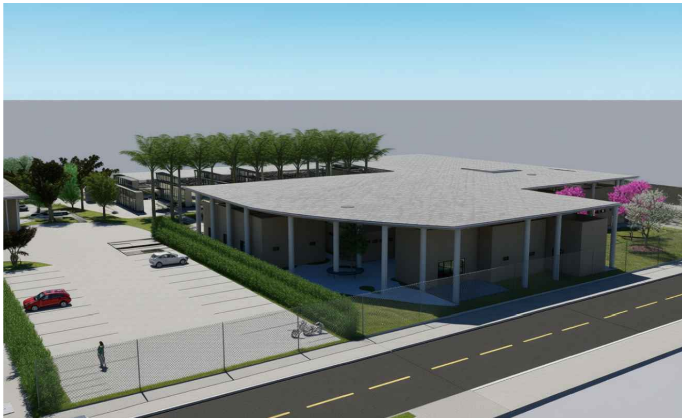
VISTA GERAL CREMATÓRIO
