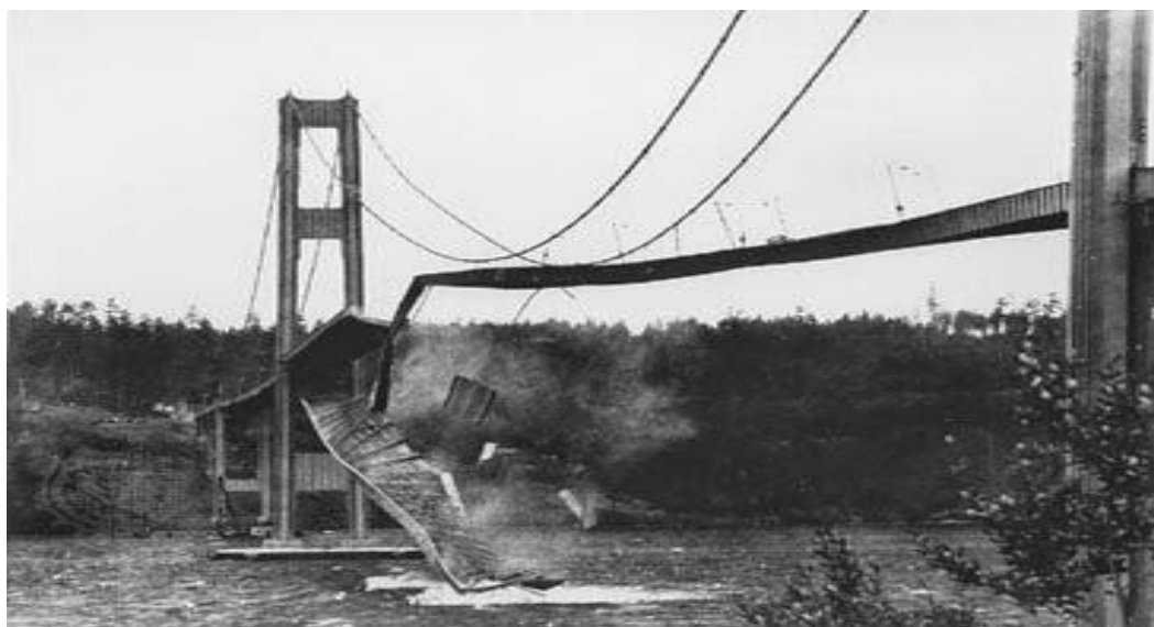
FIGURA 15 – QUEDA DA PONTE DE TACOMA
