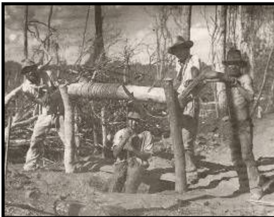
Figura 4 – Perfuração do poço. Fonte: YUBA, 1993, p. 40.
